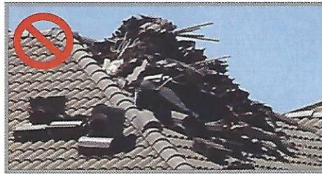
**NO** amonte materiales en un lugar que puede producir inestabilidad como en voladiza, salientes o cerca de las conexiones de trusses-a-travesa o.
